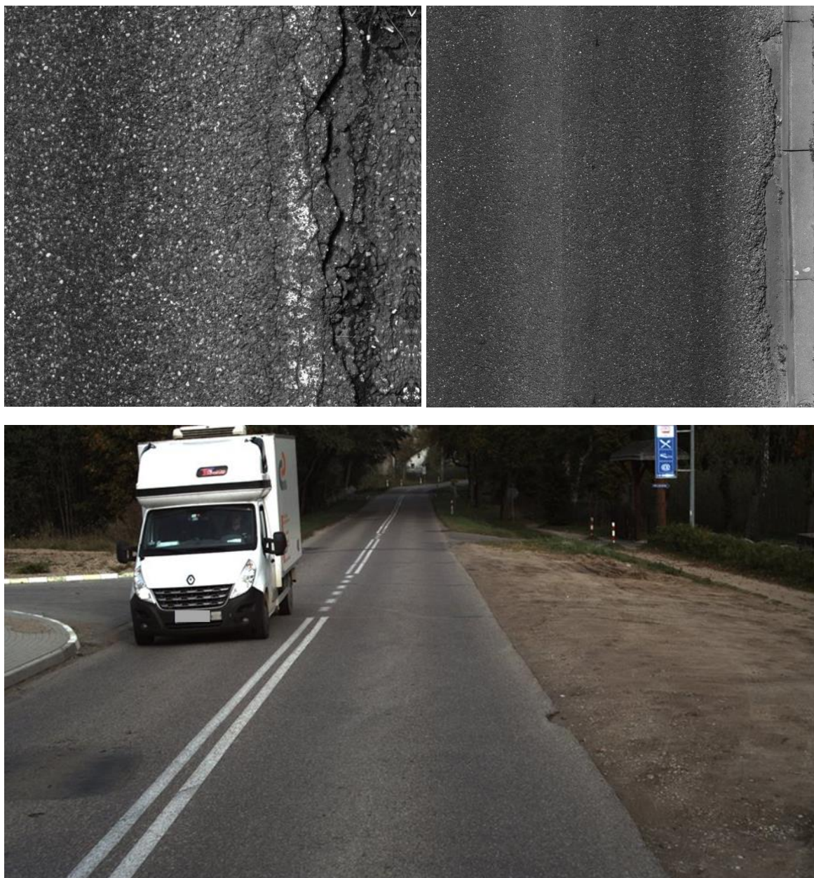
Rysunek 24: Różne przykłady uszkodzeń krawędzi (UK)
