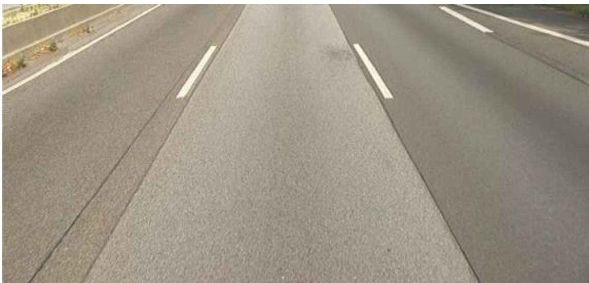
Rysunek 25: Spoiny technologiczne wzdłuż kierunku jazdy widziane na zdjęciu pasa ruchu (fragment)
